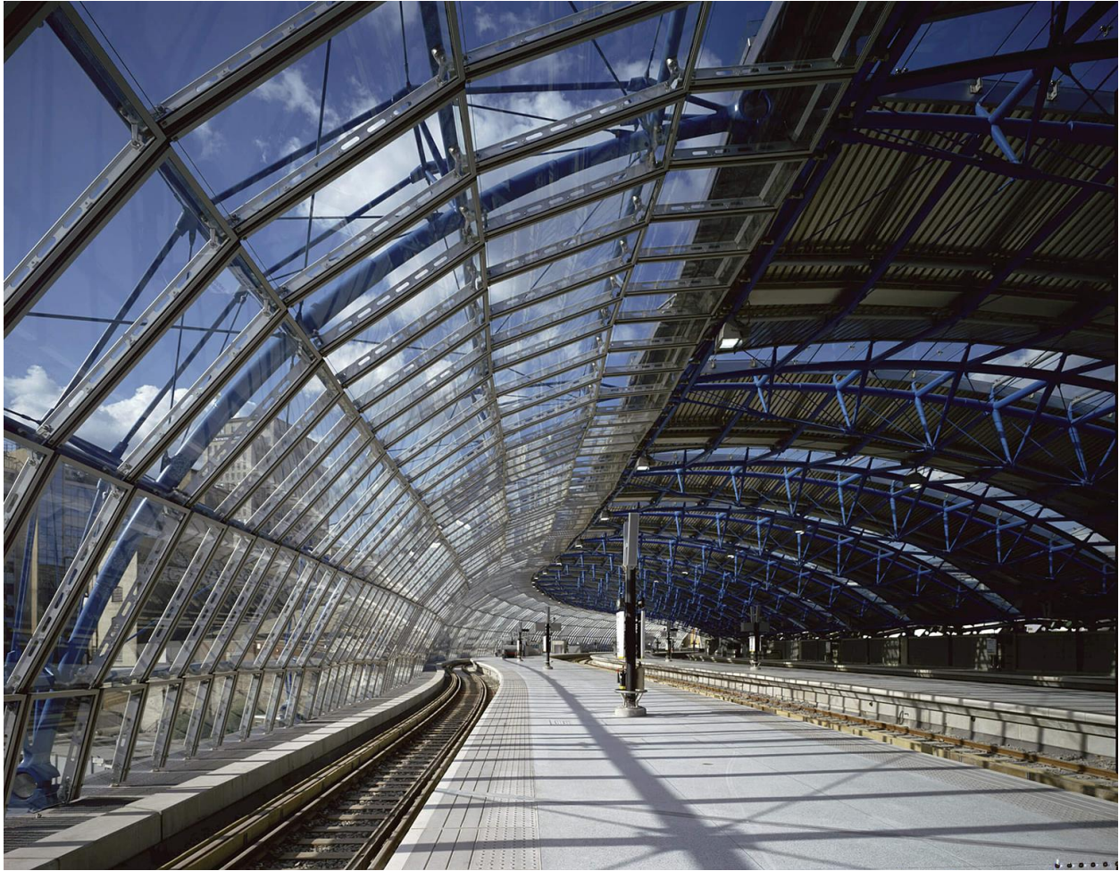
Il. 1. 36 Stacja Waterloo, projekt Nickolas Grimshaw, Londyn, Wielka Brytania, 1994. Źródło: https://grimshaw.global/projects/rail-and-mass-transit/international-terminal-waterloo/
