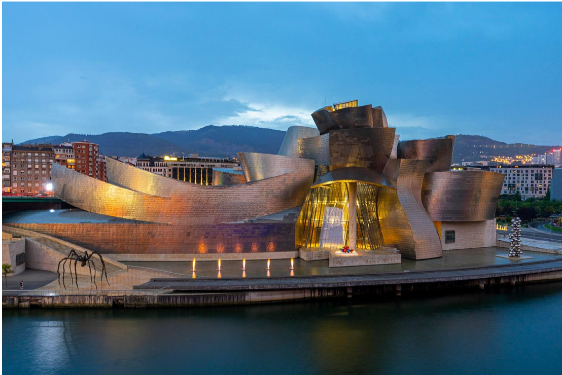
Il. 1. 18 Guggenheim Muzeum w Bilbao, projekt Frank Gehry. Źródło: https://www.guggenheim-bilbao.eus/en/the-building
