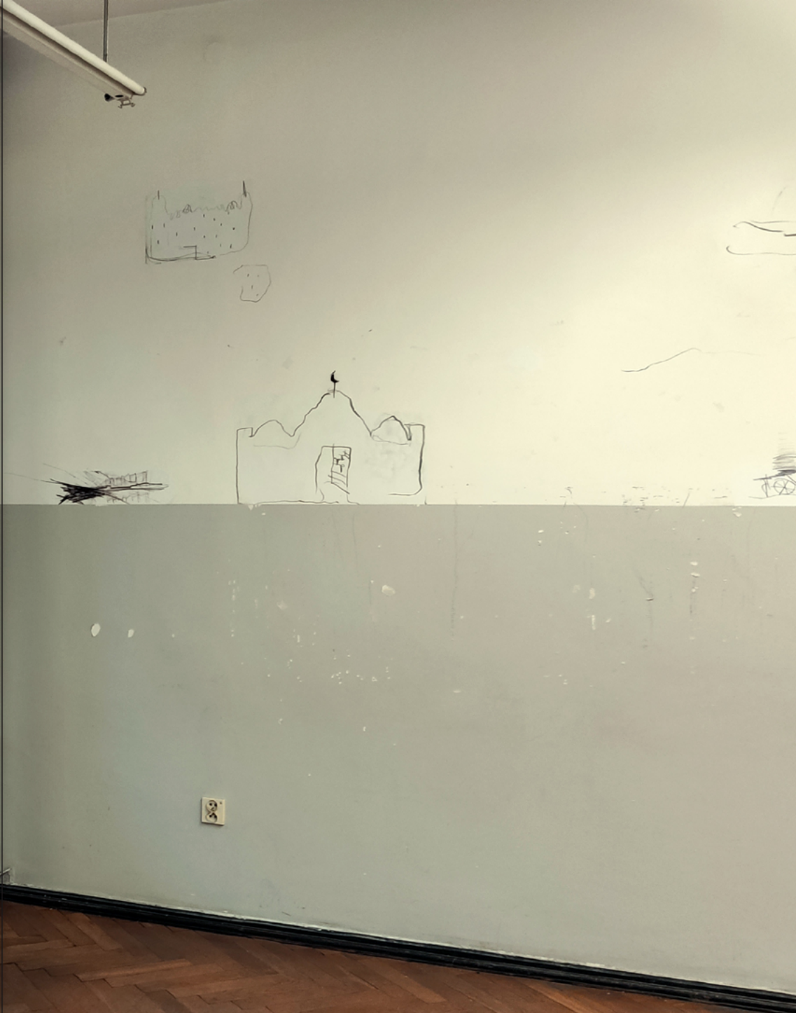
Widok ogólny, narożnik południowo-zachodni
