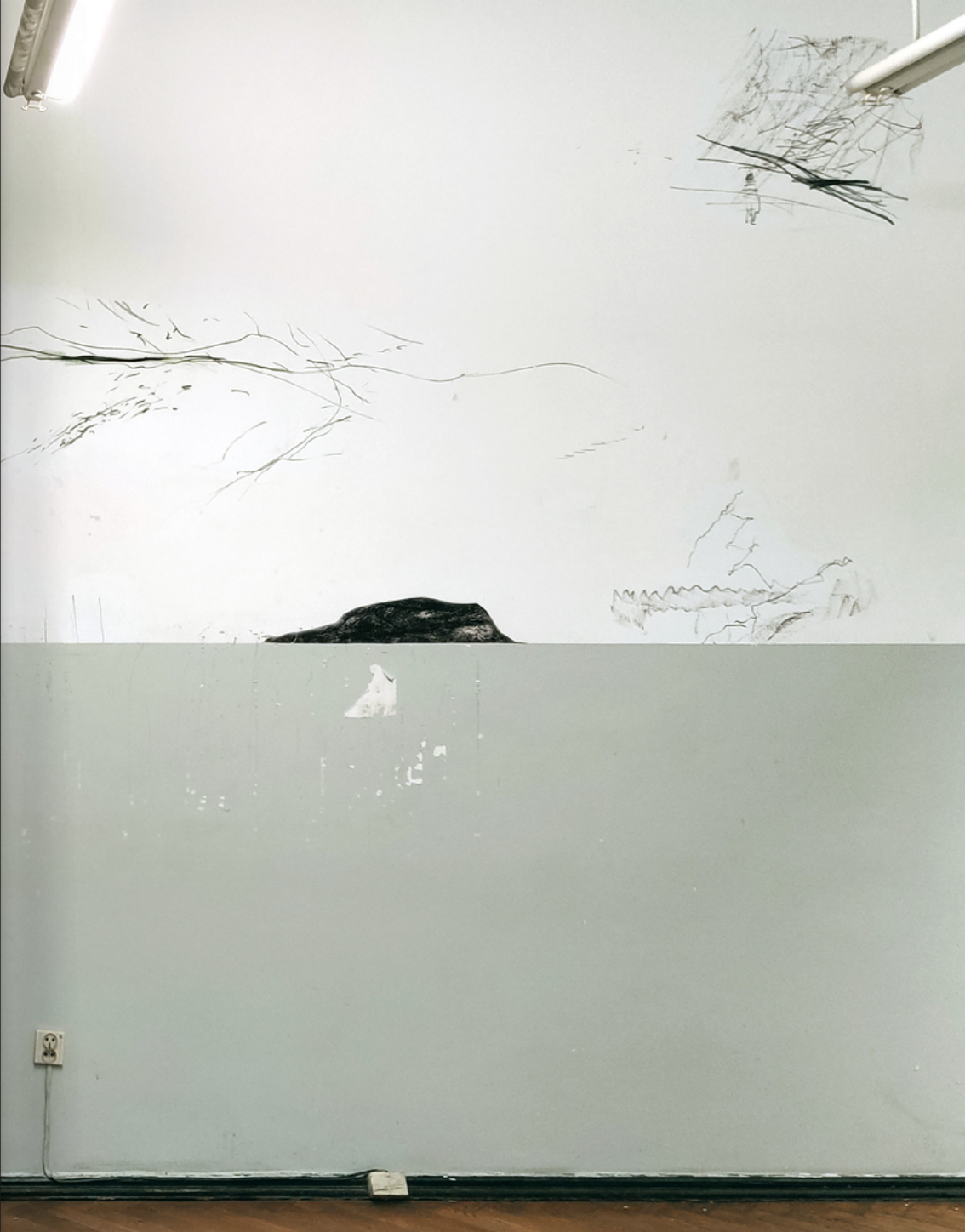
Widok ogólny, ściana zachodnia
