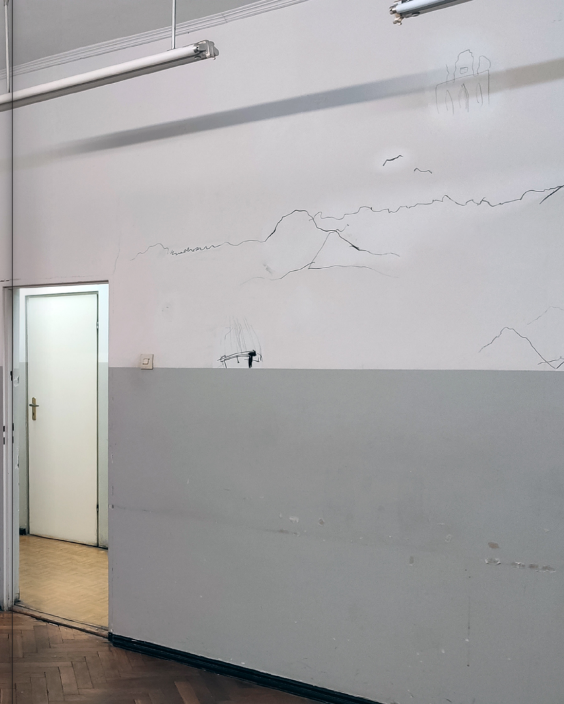
Widok ogólny, narożnik północno-zachodni
